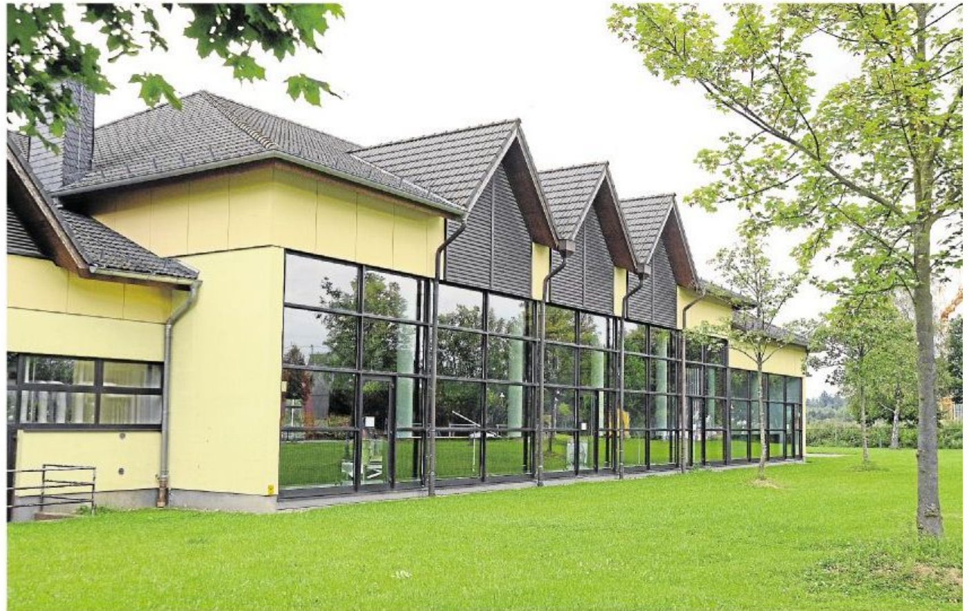
Die Stadthalle in Kirchberg wird künftig ans Nahwärmenetz der Rhein-Hunsrück Entsorgung (RHE) angeschlossen. Über die Heizzentrale am Kirchberger Schulzentrum werden dann Kirchbergs „gute Stube“ wie auch das neue Seniorenheim mit Wärme versorgt.
