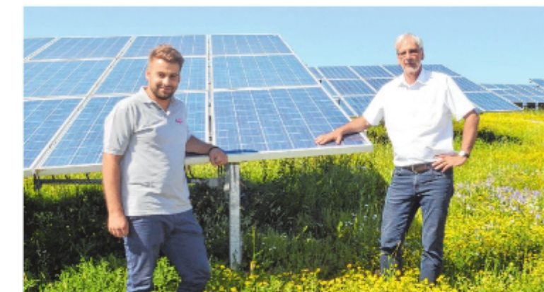
Mehr als 6 000 Solarmodule stehen auf dem Deponiekörper. Der Strom wird nun an Verbraucher abgegeben, wie Tobias Mladek (l.) und Thomas Lorenz erklären. Foto: Bender
